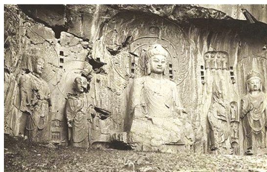
图1 奉先寺修缮加固前状况
