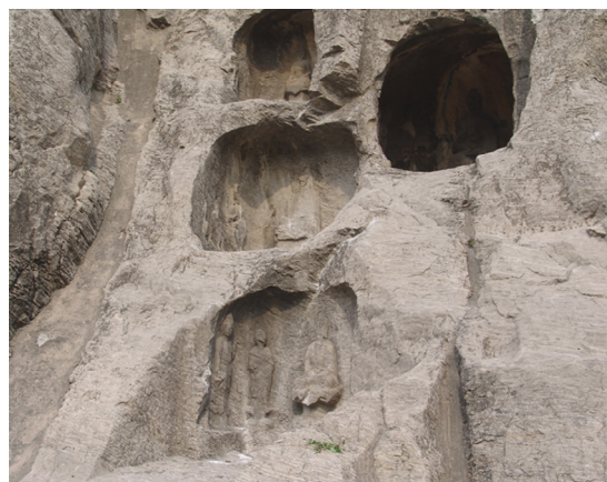
图 2 1693 号龕危岩坍塌病害状况
