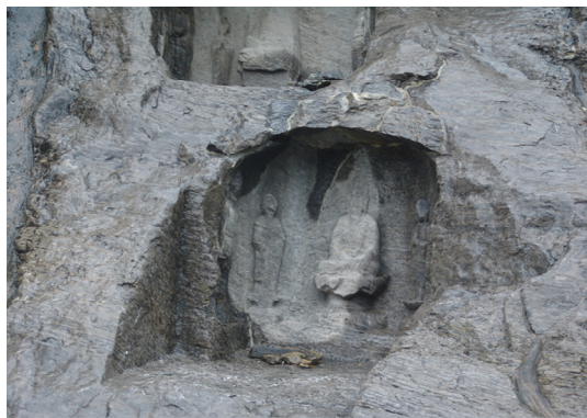
图 4 1 693 号龕日常维护修缮状况
