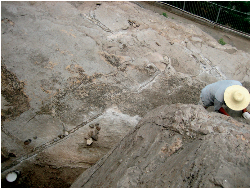
图三 环氧胶泥封堵地表裂缝
