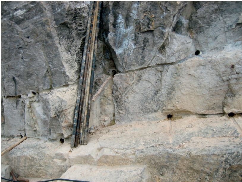
图二 层面节理水平灌浆钻孔
